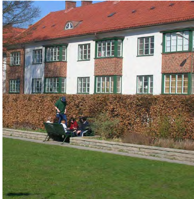
Variation mellan tegel och puts i fasaden.
