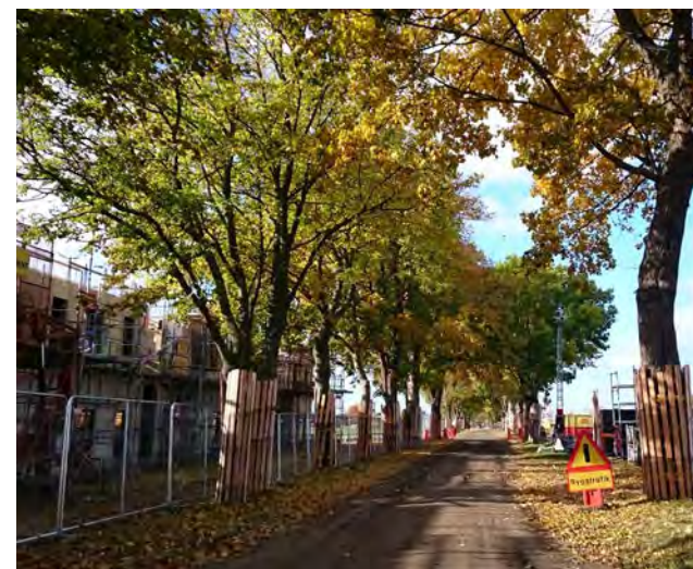
Byggnation av det första kvarteret i området.
