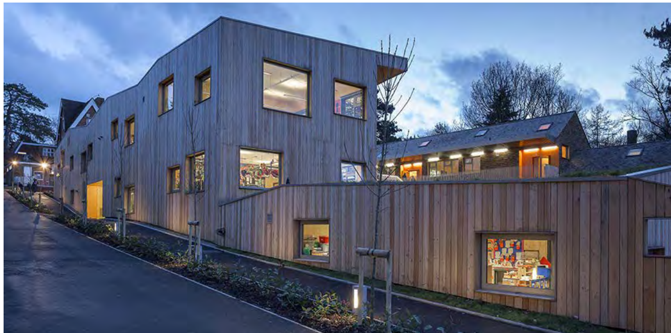
Förskola som ramar in gaturummet.
