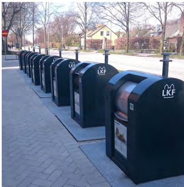
System med underjordiska avfallskärl.
