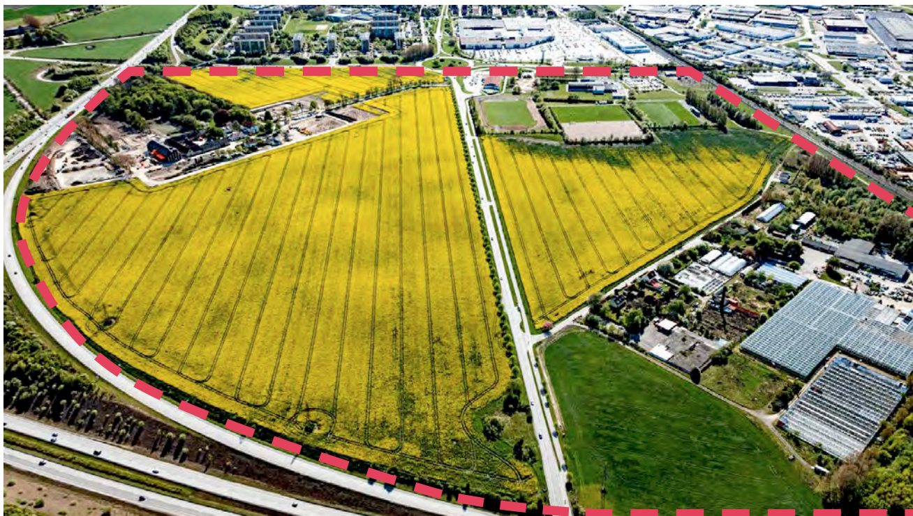
Programområdet avgränsas av motorvägen, järnvägen och Kronetorpsvägen. Lundavägen som går rakt genom området.
